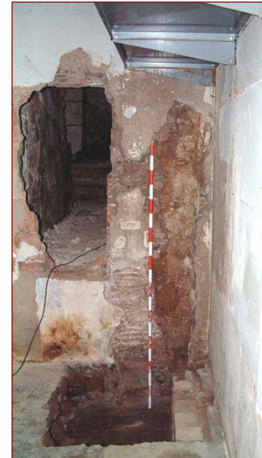
Vista general de la sala amb els testimonis (muntant i dues dovelles) de l'arc descobert en aquesta part de habitació
