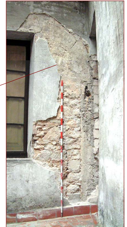
Fotomuntatge de les restes de l'arc carpanell que es descobri a l'actual pati de nivell de principal que se situa a la banda més septentrional de la planta
