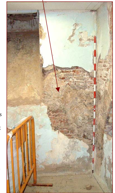
Detall de les dovelles que han estat descobertes al costat dret de l'arc. Podem veure com el seu cegat (tant a l'intradós com a l'extradós) està realitzat amb maons força moderns
