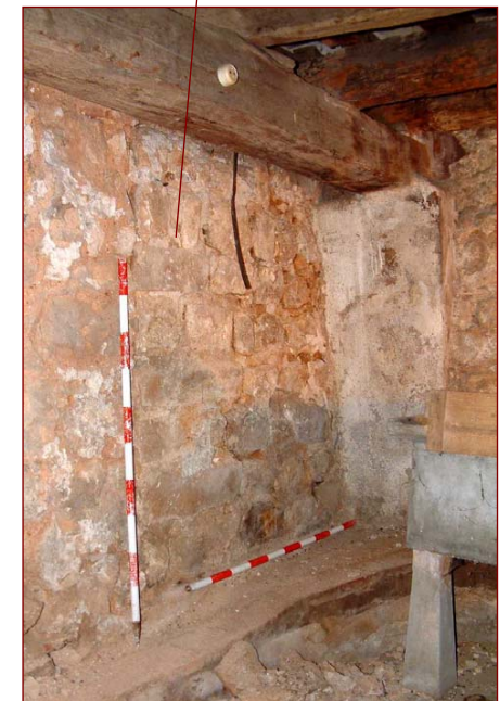
Detall de la base de l'altre pilar de l'aqüeducte romà (el més meridional) localitzat a la planta baixa
