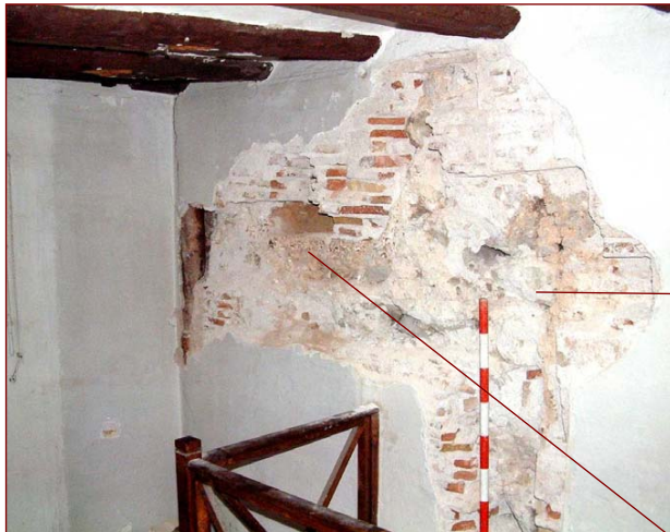
Vista parcial de la secció del pilar de l'aqüeducte en la zona que ha estat descobert el canal d'aigua de l'estructura. També ha estat identificat el seu extrem lateral més oriental. Assenyalaríem que l'accés a aquest espai es realitza des d'un altell de la planta principal
