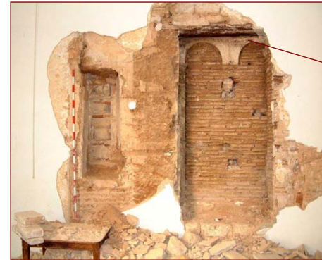
Vista general de la zona descoberta del mur més oriental de la zona sud de la planta principal. Podem distingir les dues obertures que aparegueren en el procés de repicats
