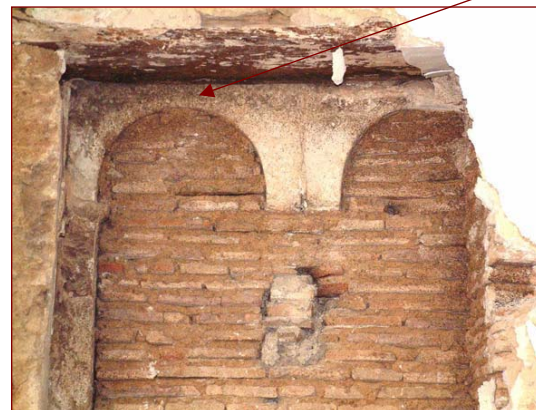
Detall de les llindes monolítiques de mig punt i de part de la imposta i brancal de la finestra coronella
