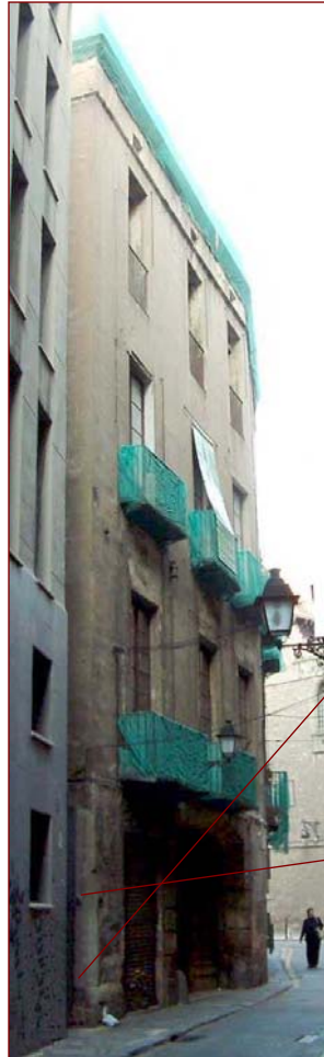
Vista parcial del costat més meridional de la façana de la finca que afronta al carrer Ripoll. S'assenyala l'actual porta metàl·lica que dóna al carrer sense trànsit.
