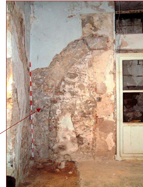
Detall dels testimonis descoberts de l'arc de la paret més occidental de la planta baixa
