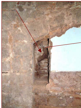
Vista parcial de la zona d'impоста de l'arc de la porta. Podem distingir l'esboranc de la intervenció i al fons la dovella de que semblaria l'arc de façana del pas
