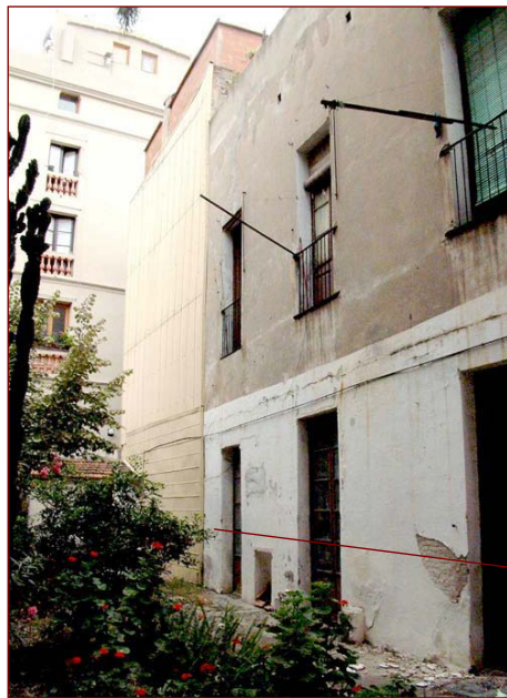
Vista parcial de la façana de la finca que dóna al jardí elevat per seu costat més occidental
