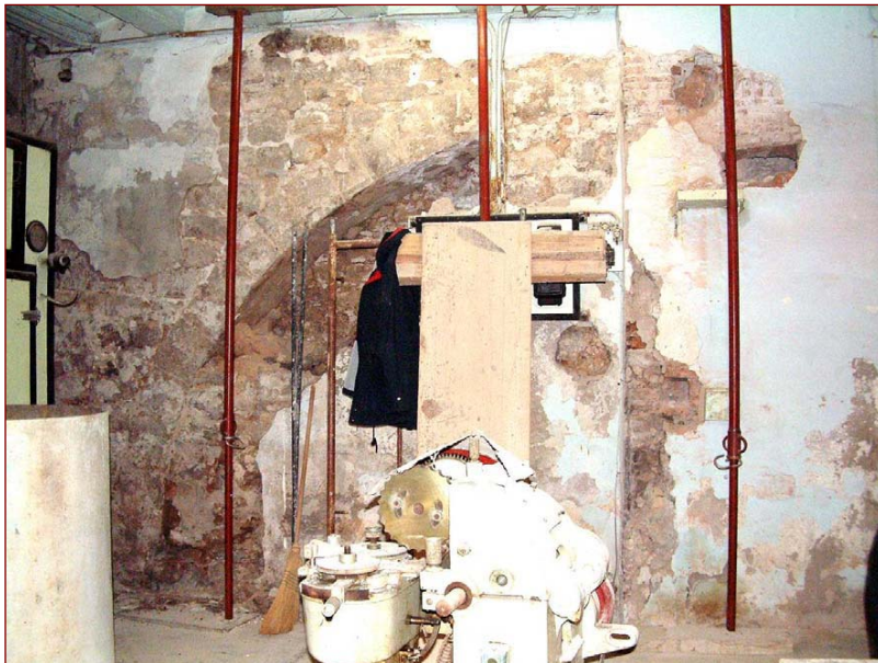
Vista general de l'arc localitzat en aquesta part de la planta baixa. Assenyalar certes diferències de disseny quan a la presència i dimensionat dels muntants entre aquest arc i els altres d'aquesta zona de la finca
