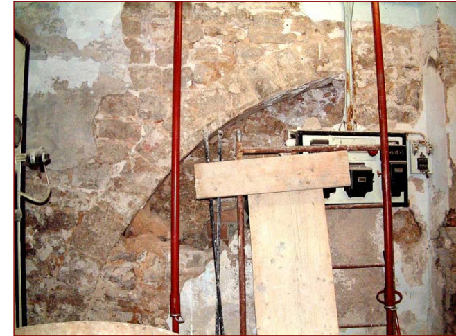
Vista parcial de l'arc de dovelles. Podem apreciar la particular estereotomia de les dovelles, força dissemblants de les que veurem en els arcs de la zona més oriental de la planta baixa
