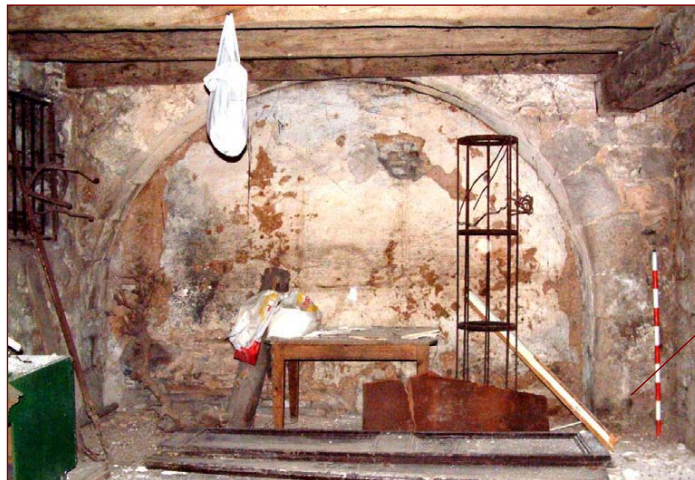
Vista general de l'arc des de l'interior de la finca
