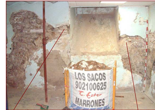
Vista general de l'arc localitzat a l'actual mestra nord de l'àmbit més meridional de la planta baixa. Podem identificar el dimensionat original de l'element, així com la finestra i claraboia que s'obre al gran jardí del pis principal
