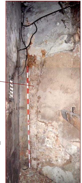
Fotomuntatge del detall de la part de l'arc descoberta des del celobert de la planta baixa de la finca. Podem distingir el seu muntant i part de les dovelles
