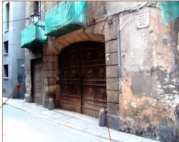
Vista parcial de la gran porta d'accés a l'escala de veïns de la finca. També s'observa un altre pas de planta baixa i la porta metàl·lica que dóna al carrer sense trànsit
