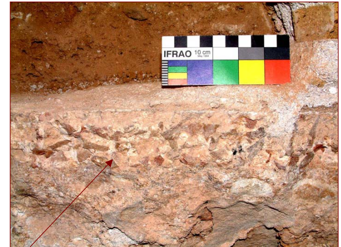
Detall de l'"opus signinum" que configura la base de la foma d'U de l'aqüeducte
