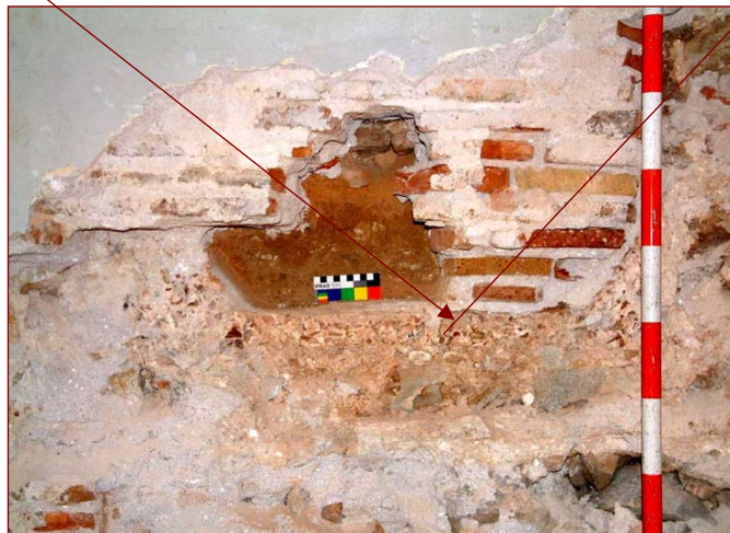
Detall de l'aqüeducte. Podem distingir la seva secció en forma de V amb de la seva configuració material en base a un tipus d'"opus signinum"
