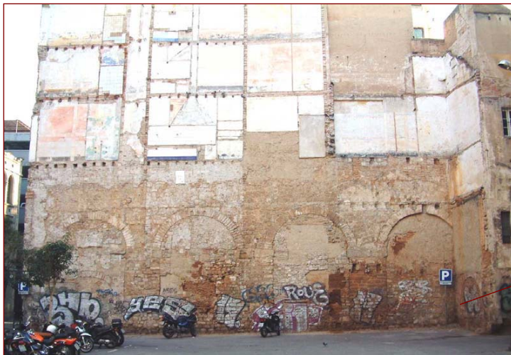
Vista general de l'alçat de l'aqüeducte romà localitzat a la plaça Duran i Bas. El pilar més septentrional descobert a la planta baixa de l'edifici del carrer Ripoll es correspon amb la continuïtat del traçat de l'estructura
